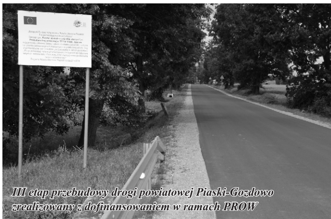
Odbiór III etapu przebudowy drogi powiatowej Piaski-Gozdowo
